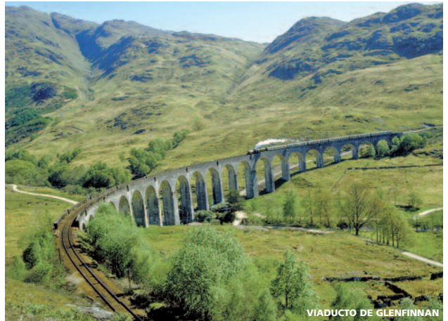
VIADUCTO DE GLENFINNAN
