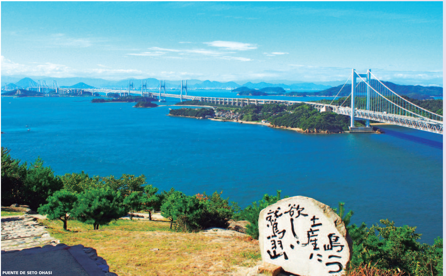
PUENTE DE SETO OHASI
